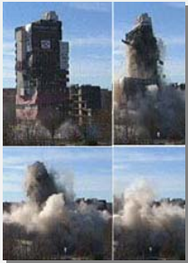
Bauwerksabbruch durch Sprengung
